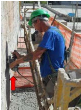
Preparação da base Remoção de pontas de ferro e tratamento com tinta anti-corrosiva
