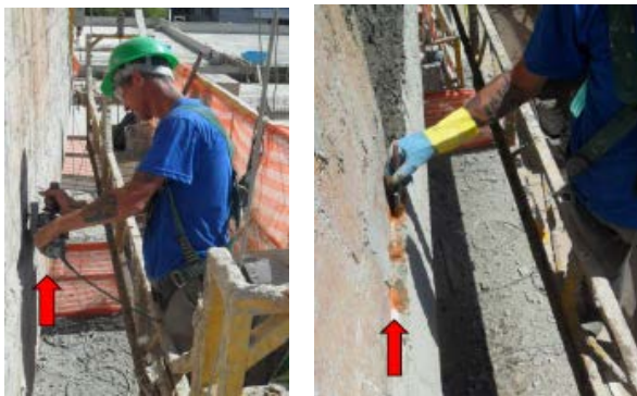
Preparação da base Remoção de pontas de ferro e tratamento com tinta anti-corrosiva
