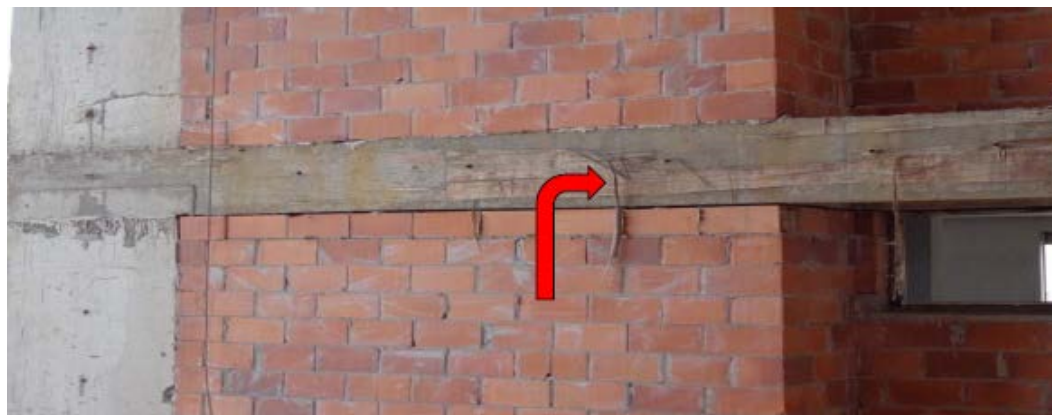
Preparação da base Remoção de resíduos de madeira
