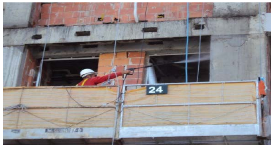
Preparação da base Lavagem das superfícies com lava-jato
